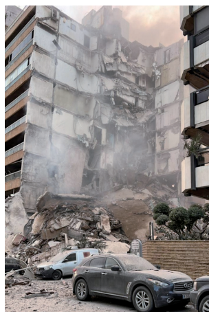
4月8日の大規模攻撃により崩壊する建物（レバノン市内中心部）
