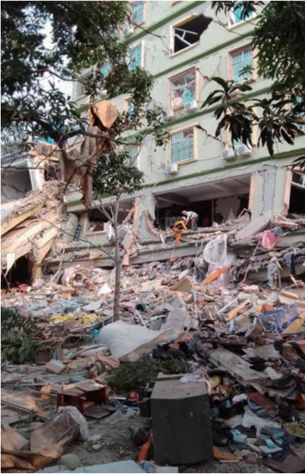
地震により倒壊した建物
