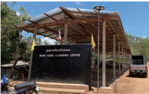
建設中のMLCの教室
