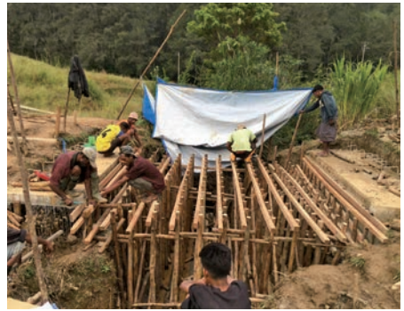
完成間近の橋
