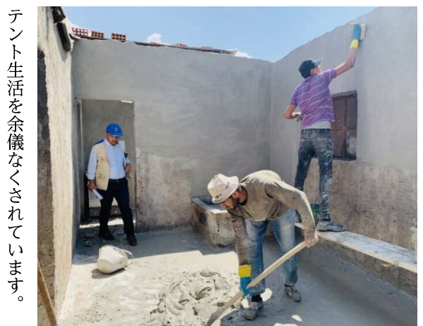
壁にヒビが入った家屋の修繕の様子
