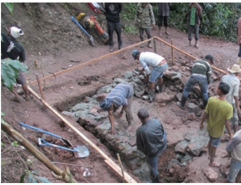
集落の住民と協力して貯水槽の土台を造成
