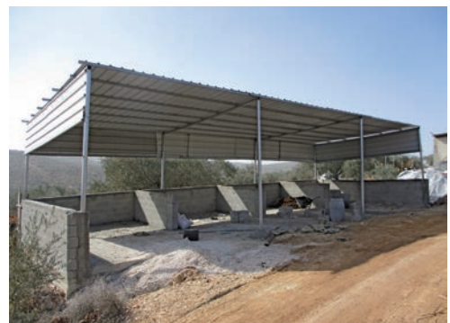
完成した堆肥舎
