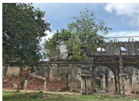
2018年夏にフィールドスタディが予定されるスリランカ北部一内戦の傷跡が残る建物
