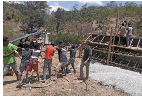
貯水槽建設の様子
