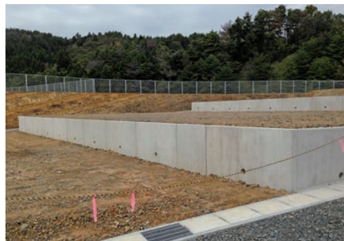
造成が進められる高台移転地
