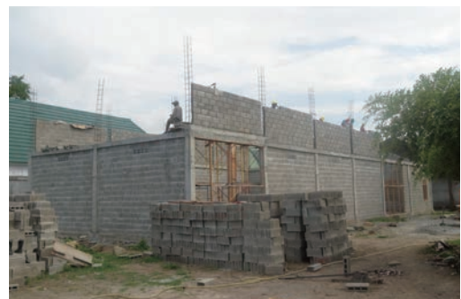
建設中の PTC 二次加工場
