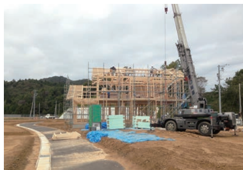
自立再建による住宅の建設
